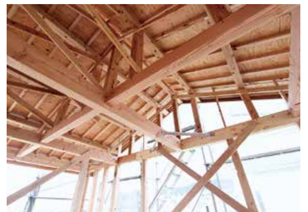
斜めに渡す「筋交い」で耐震力アップ
