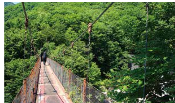
西沢渓谷の二俣吊橋(山梨市観光協会提供)
